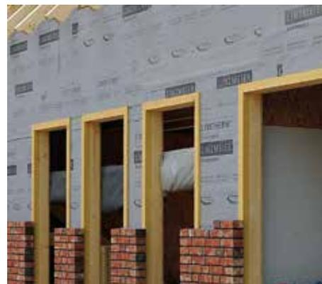
LINIREC Konstruktionsbauplatte als Fensteranschlag, Tür- und Fensterleibung
